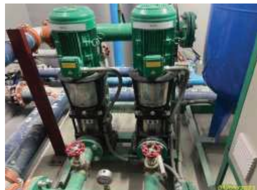
ระบบสูบน้ำขึ้นตาดฟ้า
